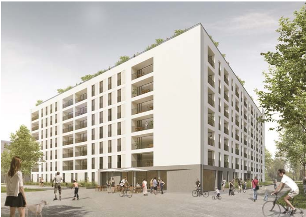
Fassadenansicht Süd-Westecke mit Bewohnertreff und ambulanter Pflege-WG (Rendering: Baumschlager Hutter Partners München)
